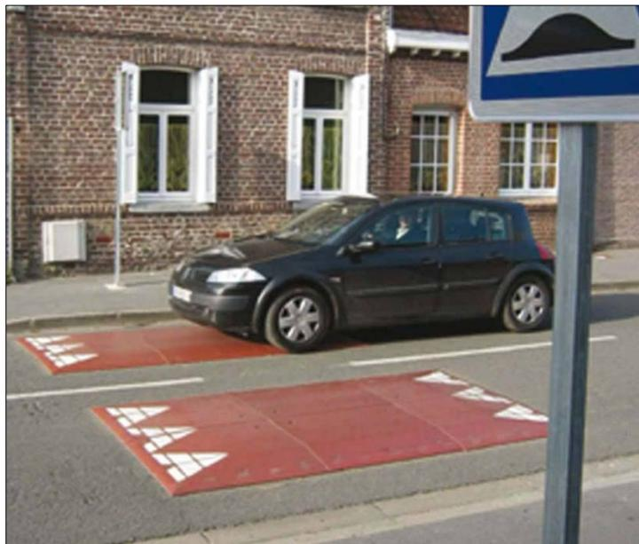
**Figura 6. Cojín Berlínés instalado en Francia siguiendo las recomendaciones del CERTU, a pesar de que este organismo no normaliza estos elementos. Tipo: Retardador de caucho con coeficiente antideslizante S.R.T. 0,53%. Por debajo de 0,45, en condiciones de humedad alta, algunos motoristas sufren accidentes por falta de agarre. Dimensiones: 1800 X 3000 X 65mm. Rojo o Negro con 3 dientes de tiburón blanco retro reflectantes. PESO: 292 Kg.**
